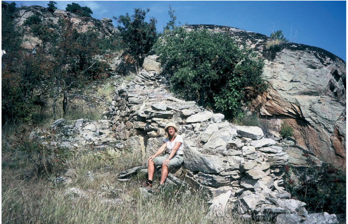
FIGUR 6. Ett stort antal befästningar av enklare slag i romarriket byggdes likt de svenska borgarna i tormursteknik. Bilden visar ett vallavsnitt av den befästa staden Gradok, Kaniste i nuvarande Makedonien. Foto författaren.
